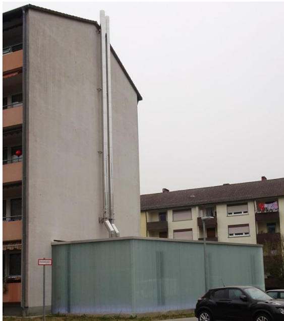
Abb. B1-4: Links: Neue Heizzentrale als Anbau an das Gebäude Ersinger Straße 5 (s. auch Abbildung auf der Titelseite). Rechts: Möblierung der Heizzentrale: links im Vordergrund der erste BHKW-Modul, in der Mitte der SL-Kessel, im Hintergrund die beiden 3 m 3 – Wärmespeicher. Ganz rechts ansatzweise der Schaltschrank mit Controller, Meßtechnik und Internet-Router.
