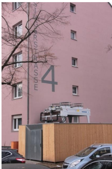
Abb. B1-5b: Viessmann-Mehrquellen-Wärmepumpe: Tischkühler auf neuem Müllhäuschen an der Ersinger Straße 4, linkes Foto, und Wärmepumpenkaskade (Fa. Viessmann) im Heizungskeller.
