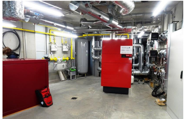
Abb. B1-4: Links: Neue Heizzentrale als Anbau an das Gebäude Ersinger Straße 5 (s. auch Abbildung auf der Titelseite). Rechts: Möblierung der Heizzentrale: links im Vordergrund der erste BHKW-Modul, in der Mitte der SL-Kessel, im Hintergrund die beiden 3 m 3 – Wärmespeicher. Ganz rechts ansatzweise der Schaltschrank mit Controller, Meßtechnik und Internet-Router.
