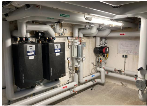
Abb. B1-5a: Links: Verwendete Nahwärmeleitung. Rechts: Hausübergabestation in der Ersinger Straße 5. Bildquelle: M. Lämmle, Fraunhofer ISE.
