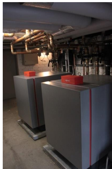
Abb. B1-5b: Viessmann-Mehrquellen-Wärmepumpe: Tischkühler auf neuem Müllhäuschen an der Ersinger Straße 4, linkes Foto, und Wärmepumpenkaskade (Fa. Viessmann) im Heizungskeller.
