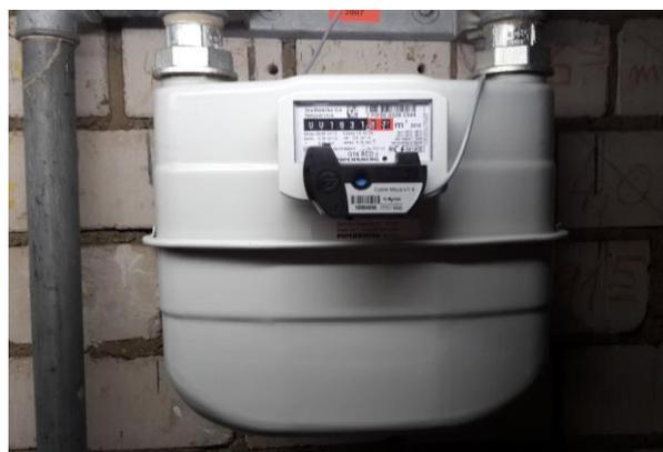
**Abb. A4-2:** Balngaszähler ,Itron ACD c G16' mit mechanischem Zählwerk und Zusatzmodul ,Cyble Mbus' zur Datenübertragung (Ausleseintervall: 1 Minute).
