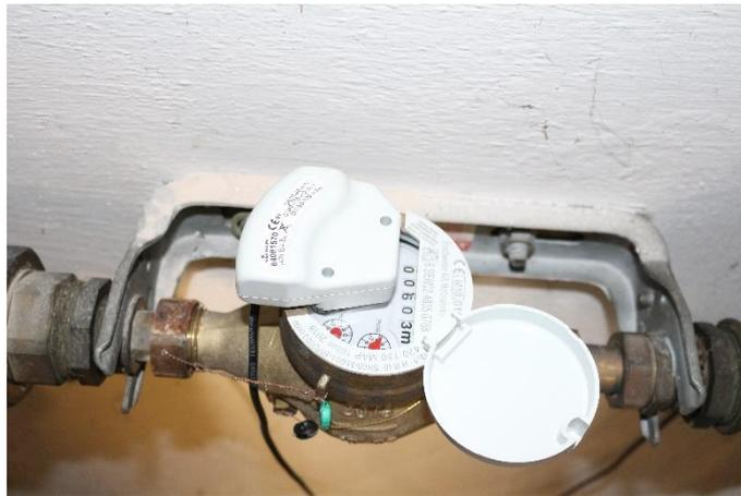
**Abb. A4-14:** Wasserzähler ‚Sensus 420‘ mit MBus-Zusatzmodul ‚HRI-B4‘ zur Datenübertragung (Ausleseintervall: 1 Minute)
