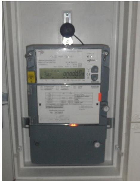
**Abb. A4-3:** Elektronischer Lastgangzähler ‚Landis & Gyr E650‘ (Ausleseintervall: 15 Minuten)
