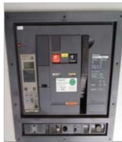
Figura 5-40: Interruptor seccionador
