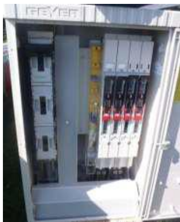
Figura 5-38: Porta-fusible con función de separar
