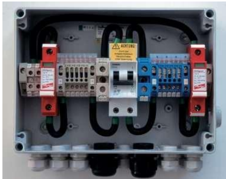
Figura 3-51: Caja de conexiones del generador [Fuente: DGS-Berlín]
