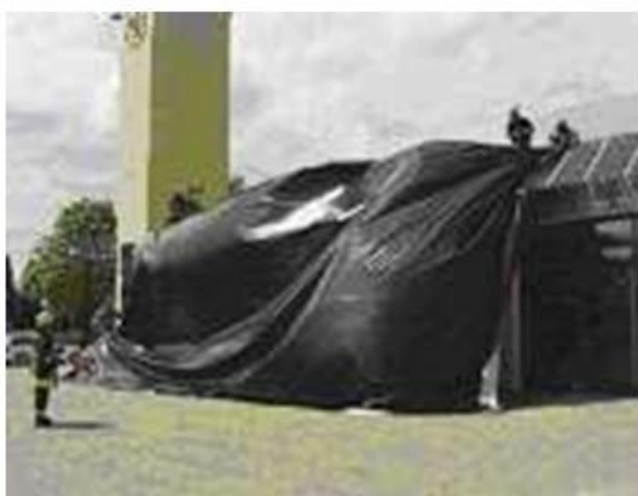
Figura 5-44: Intentos de cobertura opaca de módulos FV, foto: http://pv-notaus.de/gefahren.html
