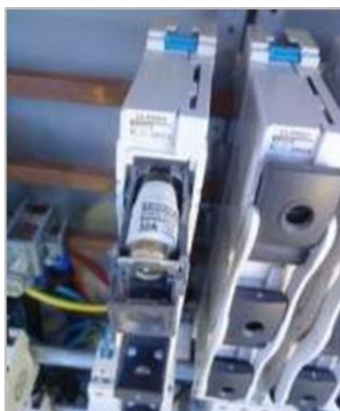
Figura 5-39: Separador con fusible
