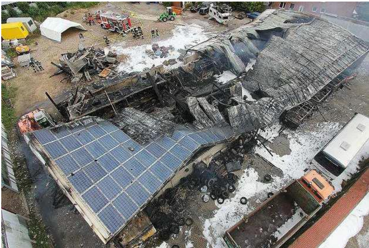
Figura 3-9: Después del incendio de un almacén y de un taller de vehículos (Foto: compañía de bomberos de Norderney).
