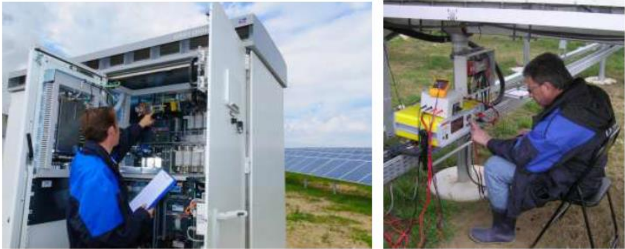
Figura 5-34: Control visual (izquierda en el WR) y medición (derecha en el GAK) durante la recepción
