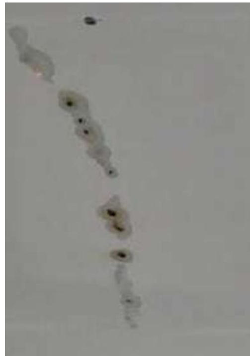
Figura 5-6: Huellas a lo largo de la grieta de celda, debidas a la carbonización y arcos
