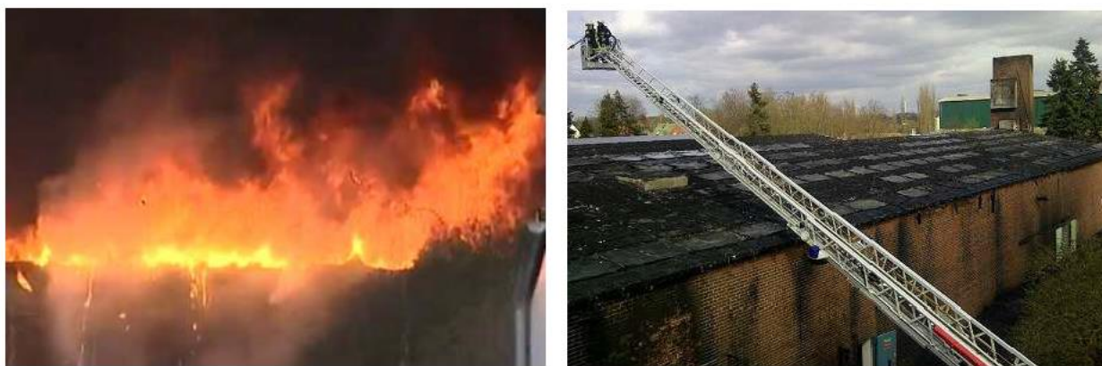
Figura 3-34: Evento que provocó el arco eléctrico en una planta FV instalada sobre el techo. Izquierda: betún de la membrana del techo ardiendo, con densas formaciones de humo y goteando en llamas. A la derecha: por suerte pudo salvarse el edificio. Fotos: Voluntarios del cuerpo de bomberos de la ciudad de Goch.
