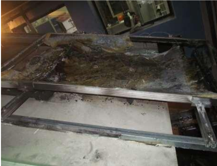
Figura 4-38: Restos del incendio de 2 módulos CIGS: Marcos de aluminio, vidrio fundido, residuos plásticos aglutinados, hollín y cenizas.
