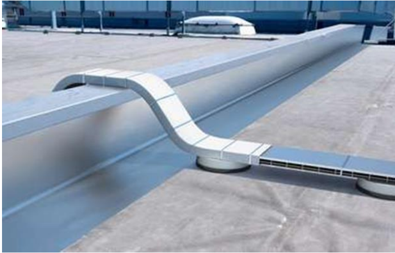
Figura 5-25: El vendaje de protección contra incendios puede prevenir la transmisión de incendios por sobre muros cortafuegos. Foto: OboBettermann, [73]
