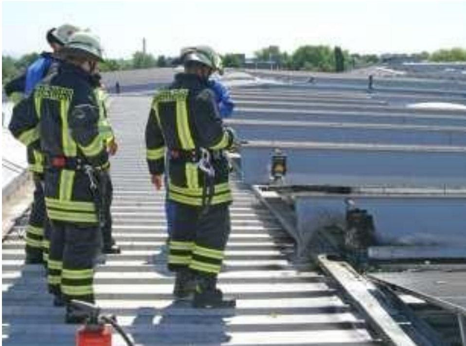
Figura 3-22: Incendio en una caja de conexiones del generador. En el centro de la foto se ve una caja del mismo tipo constructivo que no posee ningún techo protector (Fuente: Cuerpo de voluntarios de bomberos de la ciudad de Bühl).
