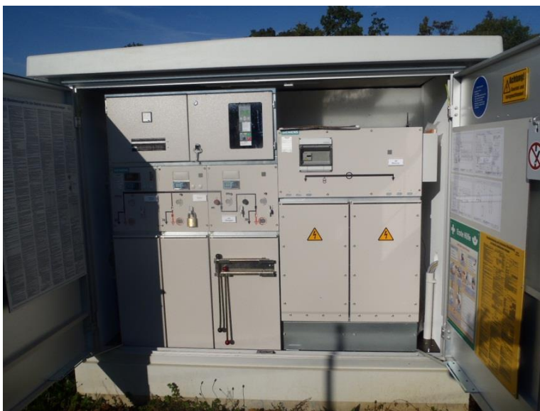
Bild 5-41: Mittelspannungsschaltstation
