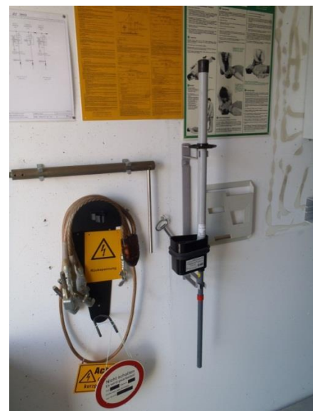
Bild 5-42: Erd- und Kurzschluss-Kit für den Transformator
