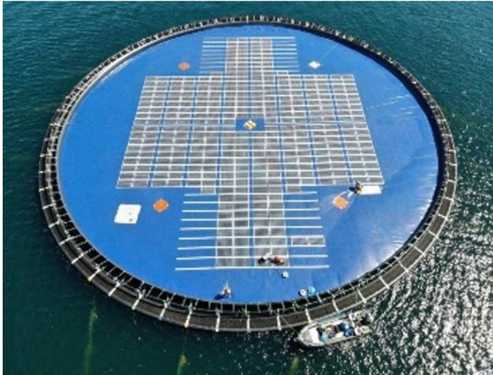
Abbildung 12: Membranbasierte FPV-Anlage ©Ocean Sun
