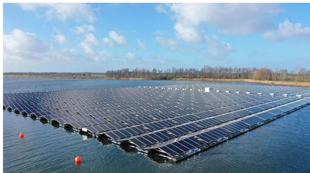
Abbildung 11: FPV-Anlage mit Ost-West-Aufständigung ©Zimmermann PV-Stahlbau
