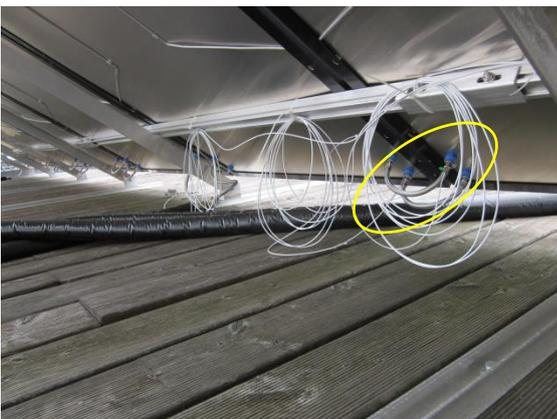
Rohranlege-Temperaturfühler (Spezialentwicklung) installiert
