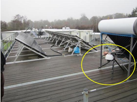
Kamera (vorne rechts) installiert. Dokumentation von Kondensat und Eis (Bild / 20sec)
