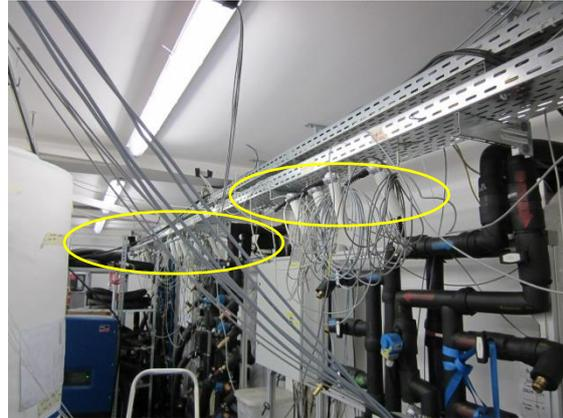
Fluidtemperatursensoren, vorbereitet zur Installation
