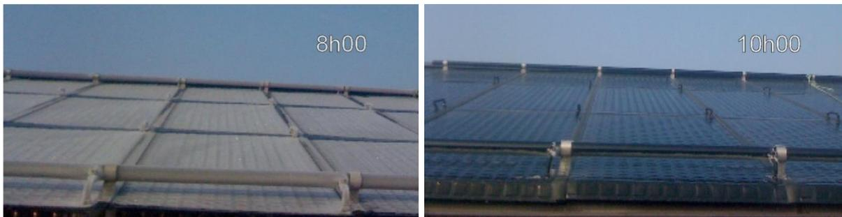
Abbildung 2: Exemplarisch wird in [10] bei einer Feldanlage, die über ein Jahr kontinuierlich vermessen wurde, ein Tag im März analysiert. Die Abbildungen zeigen gefrorenen Tau auf ungedeckten, selektiv beschichteten Kollektoren am Morgen (Bild links).
