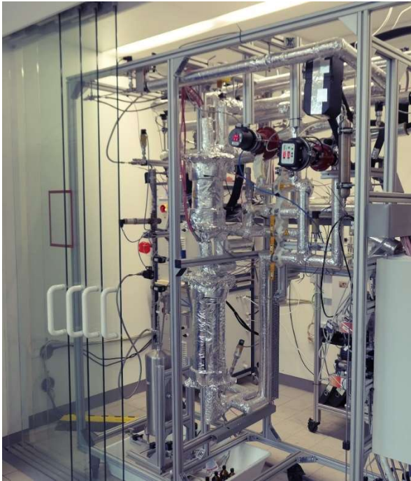
Miniplant für die Umwandlung von Hüttengasen in Methanol. © Fraunhofer ISE
