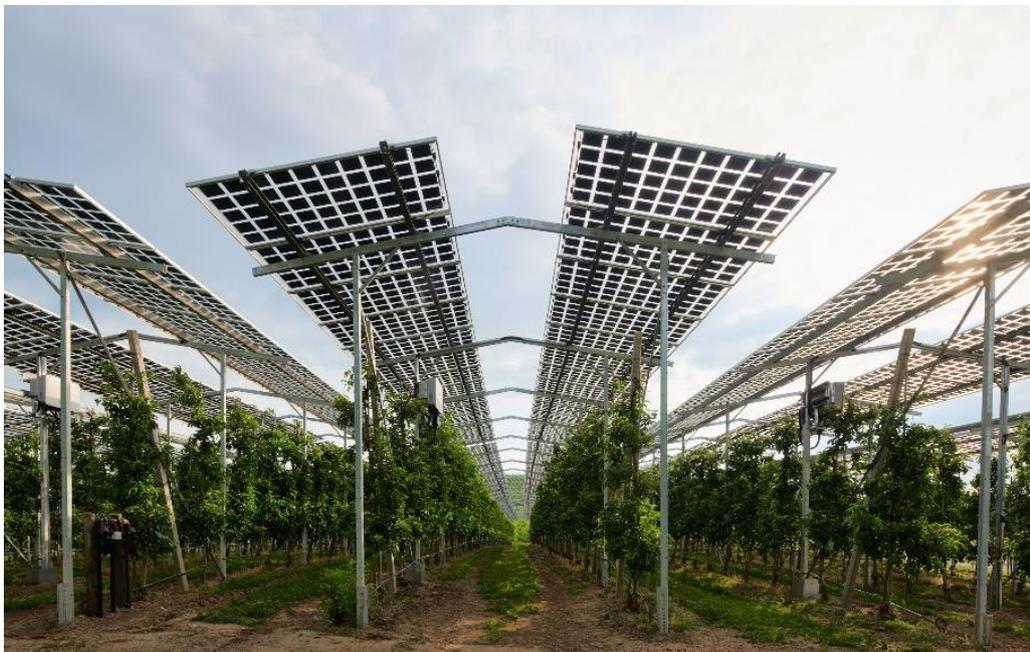
**Kernobst, wie Äpfel, profitiert besonders von der Schutzwirkung durch Photovoltaik-Module, die hier Hagelschutznetze ersetzen. © Fraunhofer ISE**
