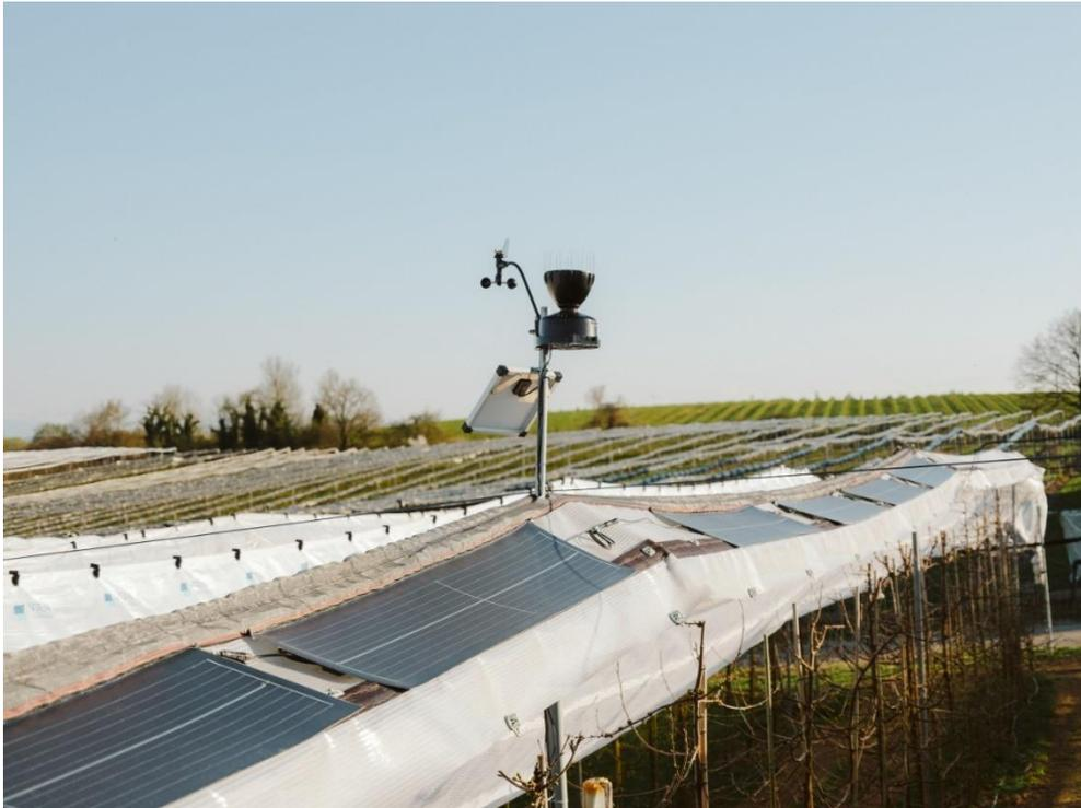
**Das Fraunhofer ISE und die VOEN Vöhringer GmbH & Co. KG haben PV-Module entwickelt, die leicht genug sind, um auf klassischen Witterungsschutzsystemen für Sonderkulturen aufgebracht zu werden.**
