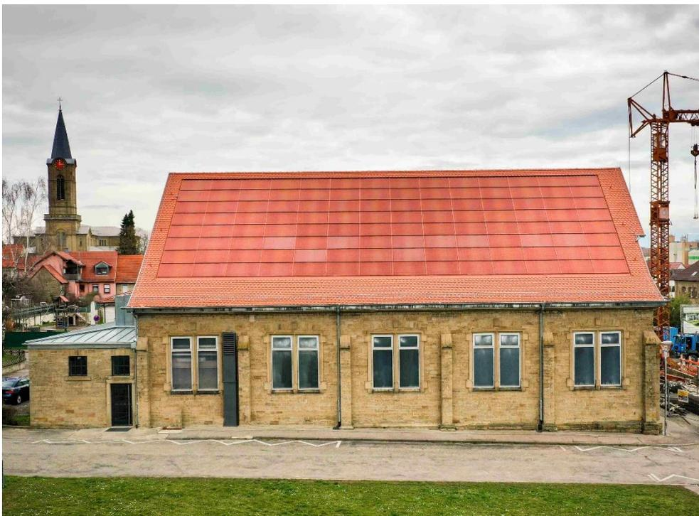
**Abb. 1** Historisches Gebäude in Eppingen mit einer roten, ins Dach integrierten Photovoltaik-Anlage. Eine homogene Integration von Photovoltaik steigert deren Akzeptanz.
