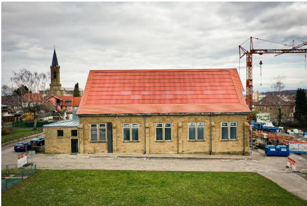
Abb. 3 Die Turnhalle mit der ziegelroten BIPV-Anlage steht in Eppingen © Fraunhofer ISE / Foto: Sarah de Carvalho
