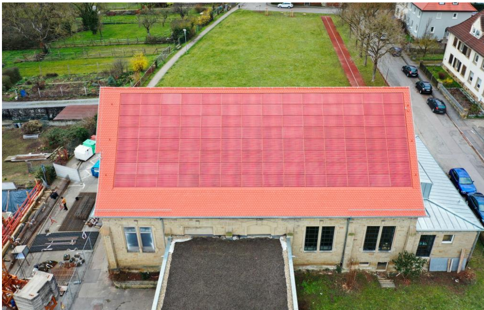
Abb. 1 Im Rahmen des Forschungsprojekts »PVHide« wurde eine ziegelrote PV-Anlage direkt in das Dach eines historischen Gebäudes integriert. © Fraunhofer ISE / Foto: Sarah de Carvalho
