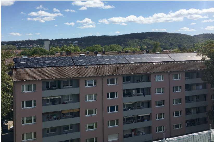
Ein Mehrfamiliengebäude im Smarten Quartier Karlsruhe-Durlach. Auf dem Dach wurde eine PV-Anlage mit 60 kW p Leistung installiert. © Fraunhofer ISE
