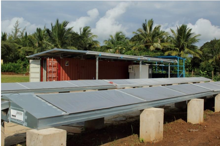
Das SolCoolDry-System besteht aus zwei Tunneltrocknern und einer Photovoltaikanlage (auf dem Containerdach) sowie der Eismaschine. ©Fraunhofer ISE
