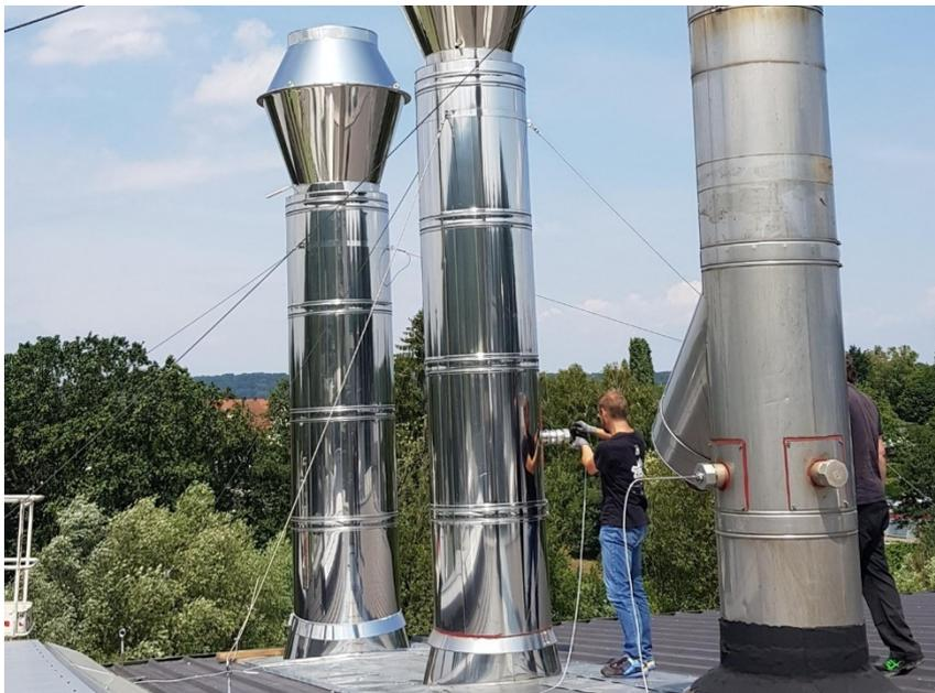
Beim Industriepartner Comet Schleifscheiben GmbH wurde das Abwärmepotenzial an allen Kaminen bestimmt und an einem davon eine Abwärmenutzung realisiert. ©Fraunhofer ISE
