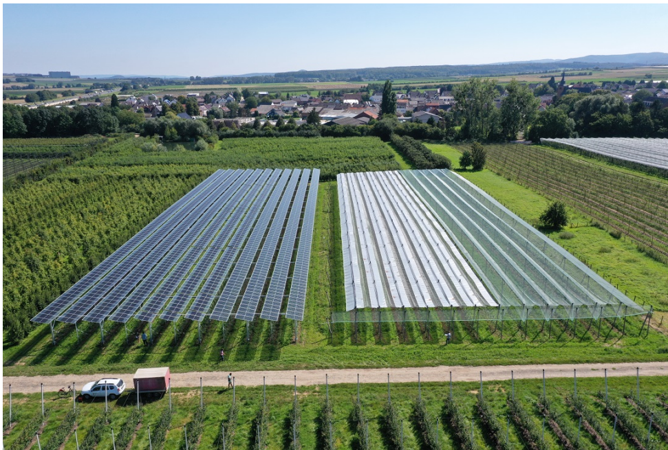
Im Projekt »Agri-PV Obstbau« werden verschiedene Solarmodul-Technologien (links) und herkömmliche Kulturenschutzsysteme (rechts) getestet. © Fraunhofer ISE
