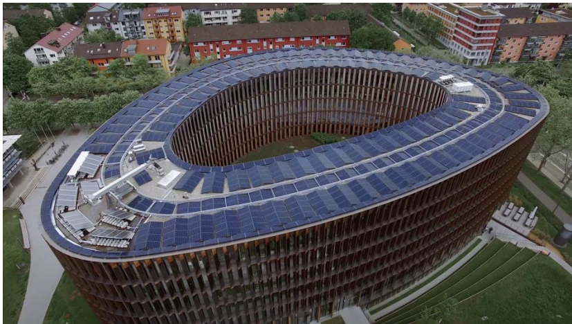
Dach und Fassade des Gebäudes werden aktiv zur Energiegewinnung genutzt, neben der Stromerzeugung über PV auch zur Wärmeerzeugung über PVT-Kollektoren. © Fraunhofer ISE
