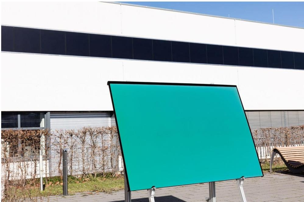
In die Fassade eines Institutsgebäudes sind 1mx1m große monokristalline IBC-Solarmodule mit Anti-Blend-Struktur und 210 Wp Leistung integriert. Würde man diese in grün – wie das Modul im Vordergrund – herstellen, hätten sie 195 Wp, also 93% der Leistung des schwarzen Moduls. Im Vordergrund der Prototyp eines farbigen Moduls für die Integration in die Fassade eines neuen Laborgebäudes des Fraunhofer ISE.
