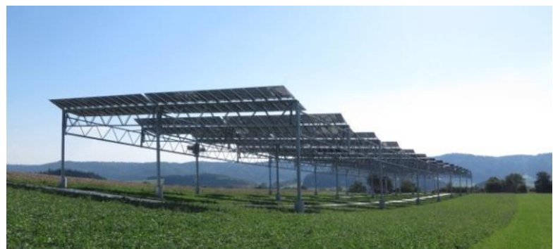
Die Agrophotovoltaik-Pilotanlage in Heggelbach am Bodensee kombiniert Strom- und Nahrungsmittelproduktion. ©Fraunhofer ISE
