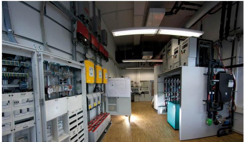
Blick ins SmartEnergyLab des Fraunhofer ISE. Die gelben Kästen beherbergen die dezentralen Agenten. ©Fraunhofer ISE
