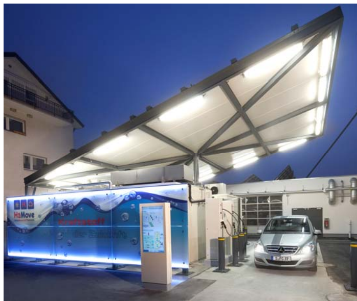
Solare Wasserstoff-Tankstelle am Fraunhofer ISE. ©Fraunhofer ISE
