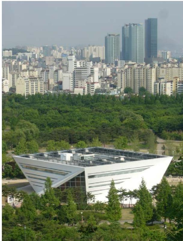
Das Energy Dream Center in Seoul wurde unter der Federführung des Fraunhofer ISE als Nullenergiegebäude realisiert. Es dient als Ausstellungs- und Informationszentrum rund um das Thema erneuerbare Energien. ©Fraunhofer ISE
