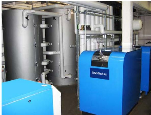
Demonstrationsanlage zur Kraft-Wärme-Kälte-Kopplung am Fraunhofer ISE. Zwei Adsorptionskältemaschinen mit einer Kälteleistung von jeweils 5.5 kW nutzen die Abwärme eines mit Erdgas betriebenen BHKWs. Die Endnutzer sind WissenschaftlerInnen des Fraunhofer ISE, deren Büroräume von der Anlage versorgt werden. © Fraunhofer ISE
