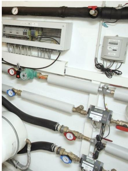
Elektro- und Wärmemengenzähler zur Untersuchung einer Wärmepumpenanlage. ©Fraunhofer ISE
