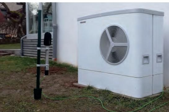
*Außenluft-Wärmepumpe mit zusätzlicher Schallmess-technik vor einem Einfamilienhaus von 1955.*
