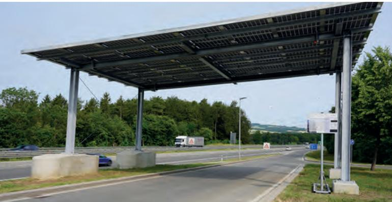
*Demonstrationsanlage einer PV-Straßenüberdachung an der Rastanlage Hegau-Ost, Baden-Württemberg.*
