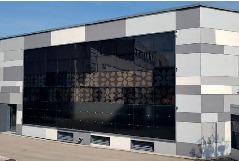
*Demonstrator am Fraunhofer ISE. Obere zwei Reihen: BIPV-Module mit kristallinem Silizium; mittlere zwei Reihen mit Ornamenten: Module mit organischer PV; die unteren drei Reihen stammen aus dem Vorgängervorhaben.*
