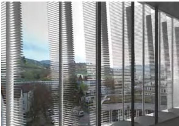
Abb. 1: Simulationsmodell des vertikal drehbaren Sonnenschutzes in der Konzernzentrale der Thyssen Krupp AG in Essen. Der Sonnenschutz kann der Sonne nachgeführt werden, so dass sowohl eine gute Sonnenschutzwirkung als auch eine sehr gute Sichtverbindung nach außen bestehen.
