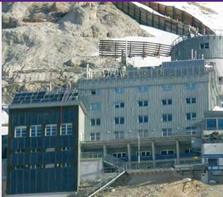
Auf dem Schneefernerhaus an der Zugspitze wurde gemeinsam mit dem TÜVRheinland eine Freibewitterungsstation für PV-Module eingerichtet. Extreme Temperaturdifferenzen, hohe Schnee- und Windlasten und ein erhöhter UV-Strahlungsanteil dienen zur Qualifizierung besonders witterungsbeständiger Produkte und als Referenz für die Entwicklung beschleunigter Beständigkeitsprüfverfahren.
