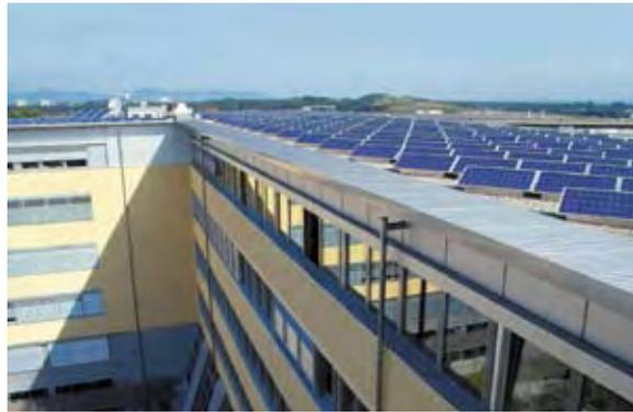
Abb. 1: PV-Anlage auf dem Solar Info Center in Freiburg: Die 2003 gebaute 50 kWp Anlage erbrachte in den vergangenen Jahren durchgehend optimale Erträge (Angaben: Einstrahlung; Ertrag; Performance Ratio):
