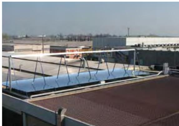
Abb. 1: Fresnel-Kollektor der Fa. PSE GmbH, Freiburg. Der Kollektor wird in Bergamo, Italien, in einer Anwendung zur Kälteerzeugung eingesetzt (NH<sub>3</sub>/H<sub>2</sub>O Absorptions-Kältemaschine). Aufgrund seiner Bauweise, bei der die Primärreflektoren parallel zum Dach liegen, bietet der Kollektor eine geringe Windangriffsfläche und lässt sich leicht in die Gebäudestruktur integrieren.
