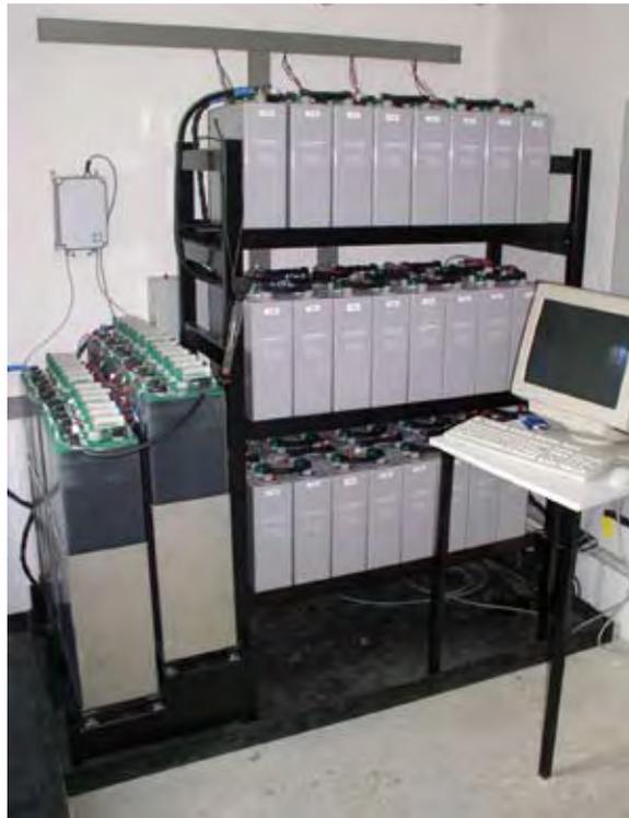
Abb. 1: Drei der vier installierten Batteriestränge im Rappenecker Hof. Das eingesetzte Batteriemanagementsystem ist in der Lage, den Zustand der Batterien (Ladezustand, Alterung) exakt zu bestimmen, optimierte Ladestrategien einzusetzen und flexibel auf das Verbraucherverhalten sowie die Erzeuger zu reagieren. Dies wird durch die Aufteilung des Speichers in mehrere parallele Stränge erreicht, die unabhängig voneinander geschaltet werden können.
