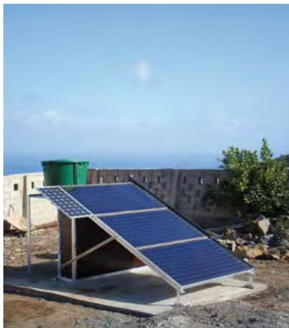
Abb. 2: Im November 2007 auf Teneriffa installierte energieautarke Kompaktanlage zur Entsalzung von Meerwasser. Die Tageskapazität beträgt ca. 120 Liter.
