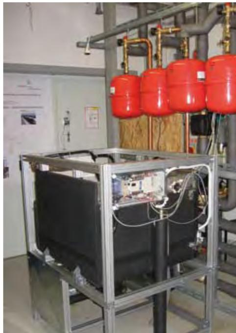
Abb. 2: Adsorptionskältemaschine mit Wärmepumpenfunktion. Die Nennkälteleistung beträgt 5,5 kW. Über das Gerät erfolgt die Zuluftkühlung für den Küchenbereich der Institutskantine. Die Antriebswärme wird von Flachkollektoren auf einer Fläche von 22 m<sup>2</sup> und aus dem Heiznetz zur Verfügung gestellt. Die Maschine ist eine Entwicklung der Fa. SorTech, eines Spin-Offs des Fraunhofer ISE, und erfolgte mit Unterstützung des Instituts.
