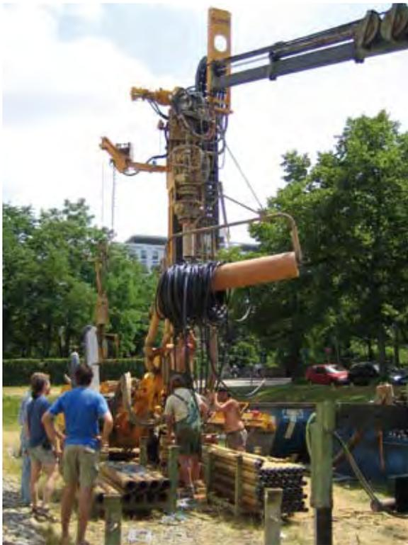
Abb. 1: Einbau von drei Erdsonden mit einer Tiefe von jeweils 80 m am Institutsgebäude des Fraunhofer ISE. Im Sommer erfolgt über die Sonden die Rückkühlung einer solarthermisch angetriebenen Adsorptionskältemaschine mit ca. 15 kW thermischer Rückkühlleistung (Abb. 2). Im Winter liefern die Erdsonden Niedertemperaturwärme für den Wärmepumpenbetrieb der Maschine.
