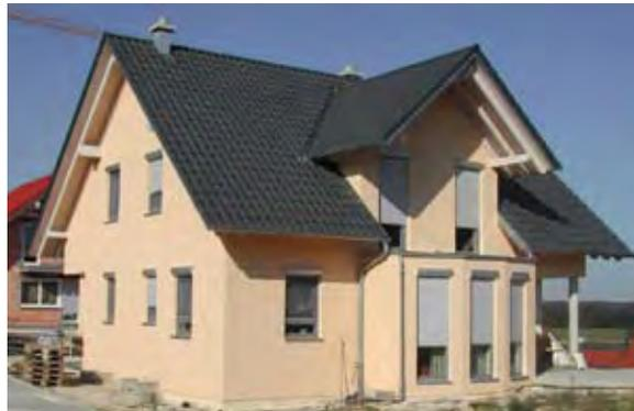
Abb. 2: Mit dem neuen VIP-Wärmedämmverbundsystem (Dicke 90 mm) ausgestattetes Demonstrationsgebäude (Einfamilienhaus bei Giengen/Brenz). Wärmedurchlasskoeffizient (U-Wert) der Wand,  $U_{W} = 0.13 \text{ W/(m}^2\text{K)}$ .
