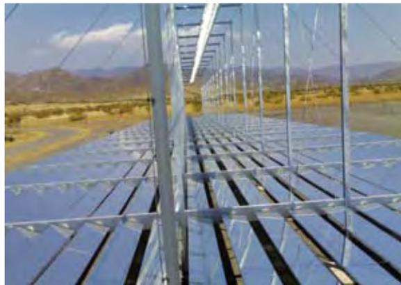
Abb. 2: Demonstrationskollektor in Almería. Der Kollektor ist hydraulisch variabel mit der Direktverdampfungsrinne verbunden, so dass unterschiedliche Betriebszustände des Kollektors (Vorwärmung, Verdampfung und Überhitzung) problemlos untersucht werden können.
