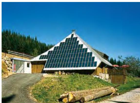
Abb. 2: Das Hybridsystem des Rappenecker Hofes besteht aus einem PV-Generator mit 3,8 kWp, einer Brennstoffzelle mit 1,2 kW, einer Windkraftanlage mit 1 kW, einem Dieselgenerator mit 9,6 kW und einem Batteriespeicher mit einer Kapazität von 62 kWh. Im Rahmen eines Praxistests unterziehen wir das von uns entwickelte Batteriemanagementsystem den Betriebsbedingungen auf dem Rappenecker Hof.
