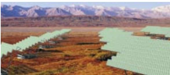
Abb. 2: Visualisierung eines Photovoltaik-Kraftwerks bestehend aus einer Vielzahl von Nachführsystemen, die jeweils mit mehreren hundert Modulen ausgerüstet sind.
