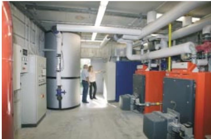
Abb. 1: Für die Strom- und Wärmeversorgung der ökologischen Solar-siedlung »Am Steinweg« in Stutensee (bei Karlsruhe) wurde von der MVV Energie AG eine BHKW-Anlage (hinten rechts im Bild) mit Spitzenlastkesseln und thermischem Pufferspeicher installiert. Die Anlage wird ergänzt um eine Photovoltaikanlage und eine Batteriebank. Das Fraunhofer ISE optimierte die Betriebsführung mit dem Energiemanagementsystem PoMS. Bildrechte: MVV Energie AG
