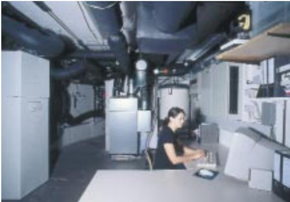
Abb. 2: Konditionierungseinheit für die Außenluft (Dämmung teilweise entfernt): Die Außenluft strömt von unten links durch den Vorkühler/Entfeuchter und den Tiefkühler nach oben zum Ultraschallbefeuchter und Lufterhitzer. Zwei Luftströme können getrennt koordiniert werden als Zuluft und als zweite Wärmequelle.
