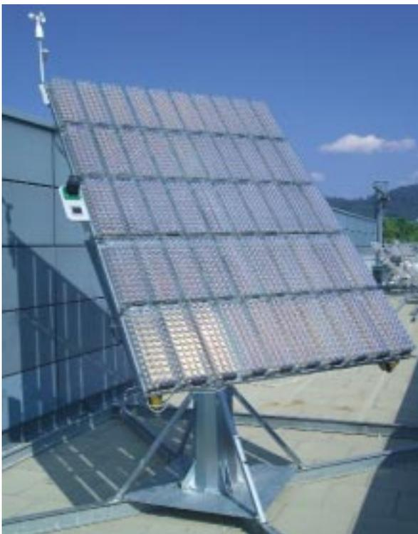
Abb. 1: Photovoltaik-Konzentratorsystem mit 50 FLATCON®-Modulen auf einer Nachführeinheit. Die optimierte Steuerung gewährleistet eine Nachführgenauigkeit von 0,1°. Das System speist die produzierte Energie in das Netz ein. Das hier abgebildete System befindet sich auf dem Dach des Fraunhofer ISE.
