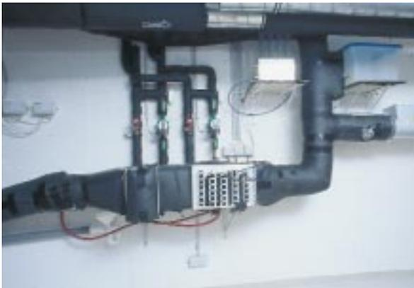
Abb. 3: Auf dem Teststand vermessenes Lüftungs-Kompaktgerät. Das Gerät ist speziell für den Einsatz im Mehrfamilien-Passivhaus entwickelt worden und hat einen kleinen, integrierten Speicher von 240 Litern.
