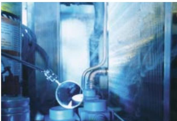
In einem Lüftungs-Kompaktgerät mit integrierter Abluftwärmepumpe wird mit Hilfe eines Luft-Luft-Wärmeübertragers und einer nachgeschalteten Wärmepumpe der Abluft soviel Energie entzogen, dass der Wärmebedarf eines Wohngebäudes gedeckt werden kann. Diese Geräte dienen der Lüftung, der Beheizung und der Trinkwassererwärmung in hocheffizienten Wohngebäuden, wie den Passivhäusern. Die Weiterentwicklung der Technik der Lüftungs-Kompaktgeräte steht im Mittelpunkt unserer aktuellen Arbeiten.
