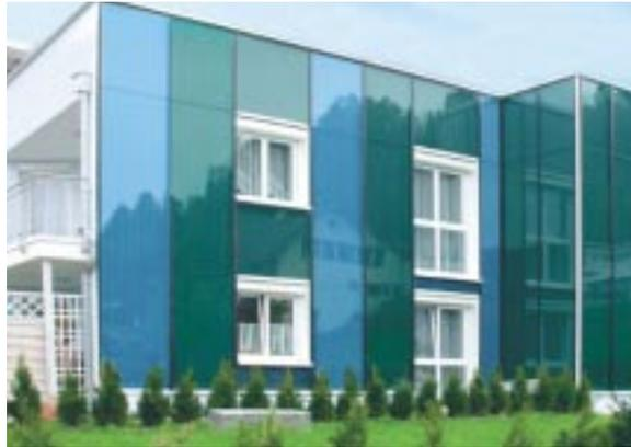
Abb. 1: Design-Studie über farbige Fassadenkollektoren (Quelle: AEE Intec).
