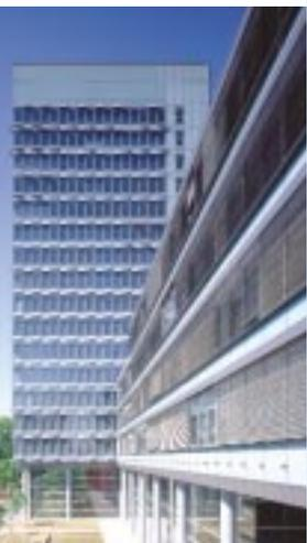
Abb. 3: Das Fraunhofer-Haus in München. Die Fassade ist doppelschalig ausgeführt und wird zur Belüftung der Büros verwendet.
