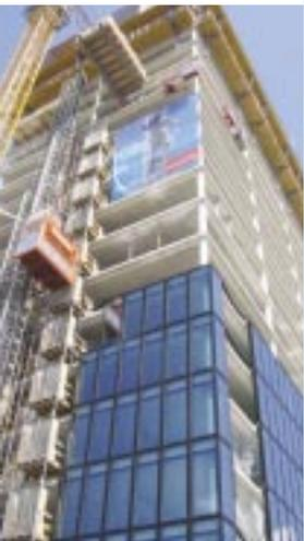
Abb. 2: Der Messturm in Basel, Schweiz. Beim höchsten Haus der Schweiz wird die Abluft aus dem Raum durch den Fassadenzwischenraum abgesaugt. Sie kühlt damit den Fassadenzwischenraum und den Sonnenschutz, der von der Abluft umspült wird. Auf dem Bild zu sehen ist die Anbringung der Fassadenelemente.
