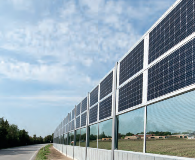
Lärmschutzwand mit integrierten Modulen. © KOHLHAUER GmbH
