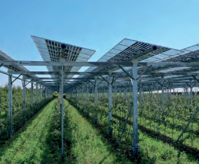
Forschungsanlage für Agri-PV im Obstbau in Rheinland-Pfalz. © Fraunhofer ISE
