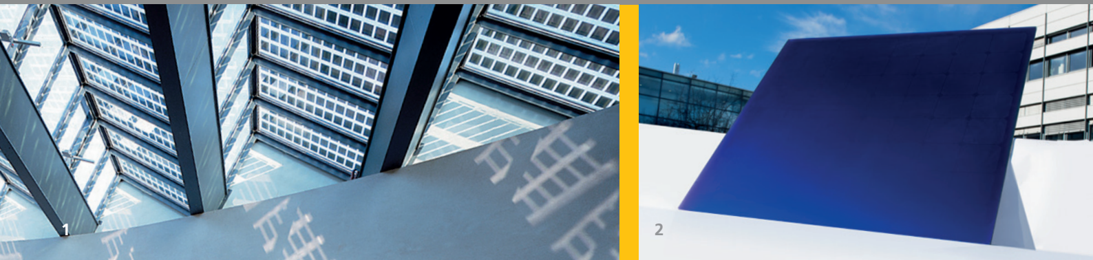
1 Halbtransparente BIPV-Module im Gebäude des Fraunhofer ISE. (Foto: Guido Kirsch)
