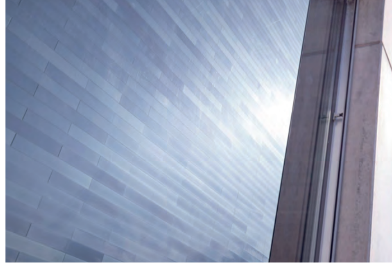
Als Fassadenelemente montierte Matrix-Schindelmodule. © M10 Industries
