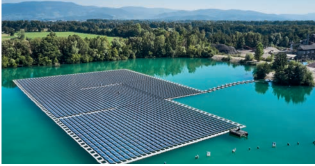
Schwimmendes PV-Kraftwerk mit einer Leistung von 750 kW bei Renchen / Baden. © Jan Oelker
