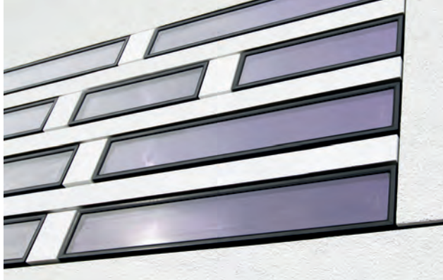
Solarthermische Streifenkollektoren integriert in eine Demonstrationsfassade. © DAW SE/Karim Donath
