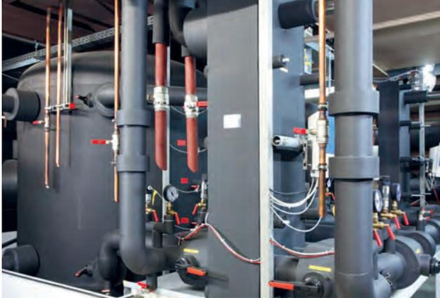
*Pilot-Kältespeichersystem mit PCM-Slurry bei ROM Technik in Hamburg. © Rud. Otto Meyer Technik GmbH & Co. KG*
