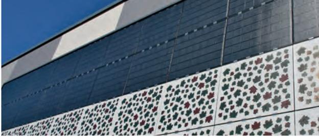
Im Projekt »Standard-BIPV« neu entwickelte BIPV-Fassade mit Modulen aus kristallinem Silicium, organischer PV und CIGS-Dünnschicht.
