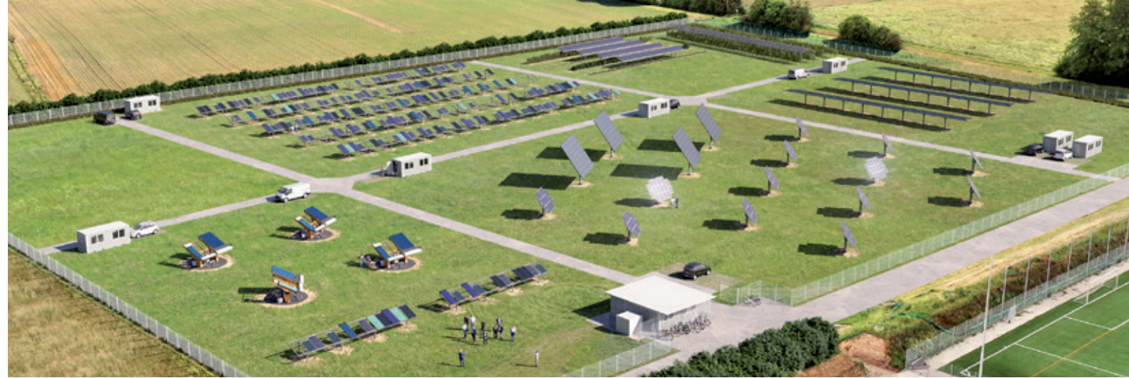
Visualisierung des Solartestfelds mit verschiedenen solaren Systemaufbauten in Merdingen bei Freiburg.
