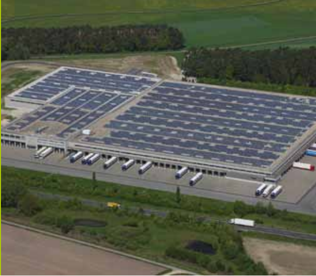
1 PV-Anlage auf dem Dach des ALDI-Zentrallagers in Adelsdorf (1.553 kWp). Foto: Pohlen Solar GmbH
