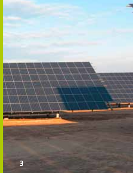
3 Teilverschattung bei einer nachgeführten PV-Anlage.
