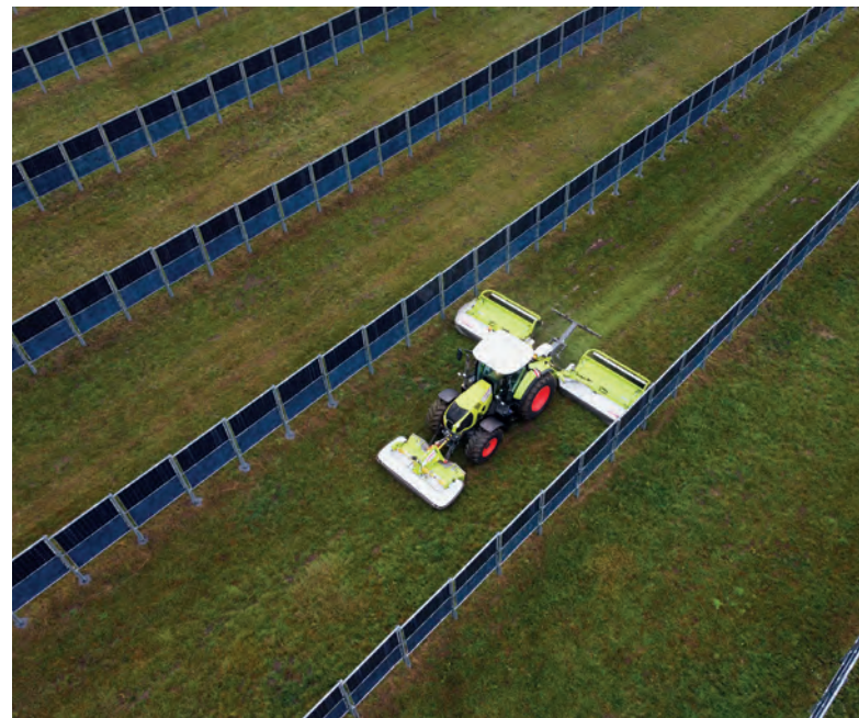
Fig. 20: Vertical agrivoltaic system in Aasen, Donaueschingen © Solverde Bürgerkraftwerke
