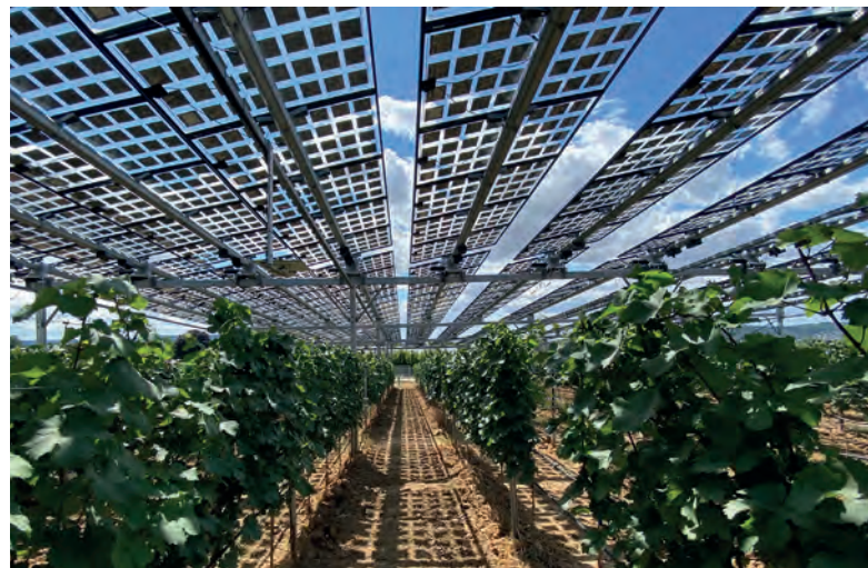
Abb. 54: Schattenwurf der lichtdurchlässigen PV-Module über Weinreben © HS Geisenheim
