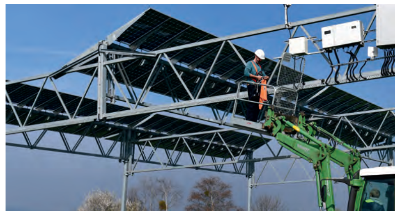
Abb. 60: Wartungsarbeiten an der Agri-PV-Anlage in Heggelbach © Fraunhofer ISE
