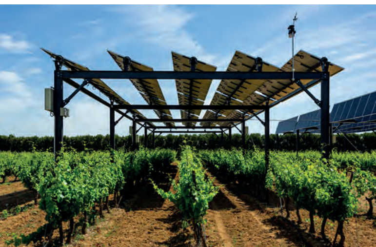
Abb. 31: Agri-PV mit nachgeführten Modulen in Frankreich © Sun'Agri
