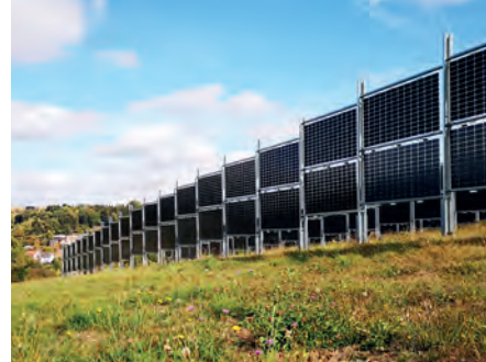
Abb. 44: Bifaziale, senkrecht aufgestellte Module von Next2Sun, Eppelborn-Dirmingen © Next2Sun GmbH
