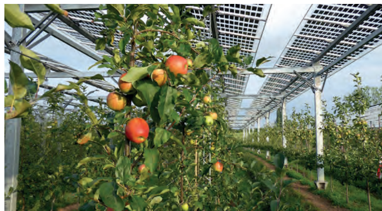
Abb. 16: Agri-PV-Anlage auf dem Bio-Obst- hof Nachtwey (2021, 2023) © Fraunhofer ISE
