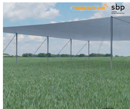
Abb. 47: Halbschatten durch Solarröhren, eingehängt zwischen Spannseilen der Firma TubeSolar © sbp sonne GmbH
