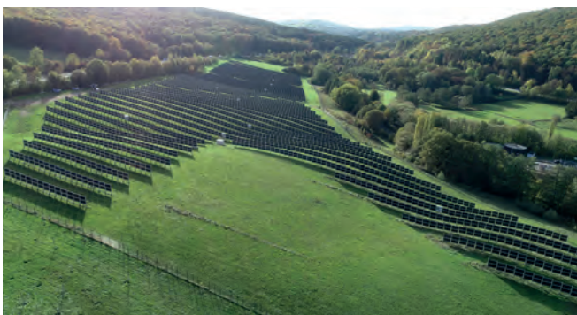
Abb. 57: Solarpark Eppelborn-Dirmingen mit 2 MW p mit vertikalen Solarzäunen von Next2Sun © Next2Sun GmbH
