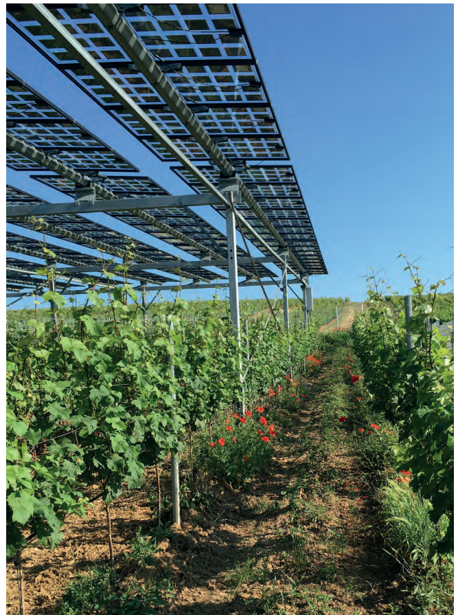
Abb. 18: Agri-PV-Anlage in Geisenheim © HS Geisenheim
