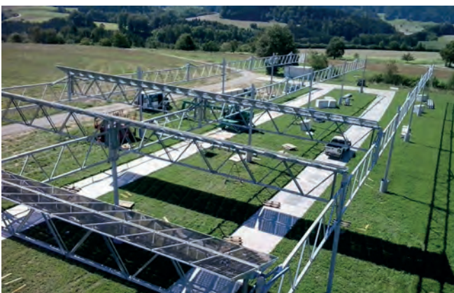
Abb. 59: Baustraßen zur Vermeidung von Bodenverdichtung © BayWa r.e
