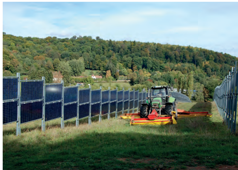
Abb. 36: Vertikal errichtete, bifaziale Module im Solarpark in Eppelborn-Dirmingen, Saarland, mit 2 MW p Leistung, errichtet von Next2Sun © Next2Sun GmbH
