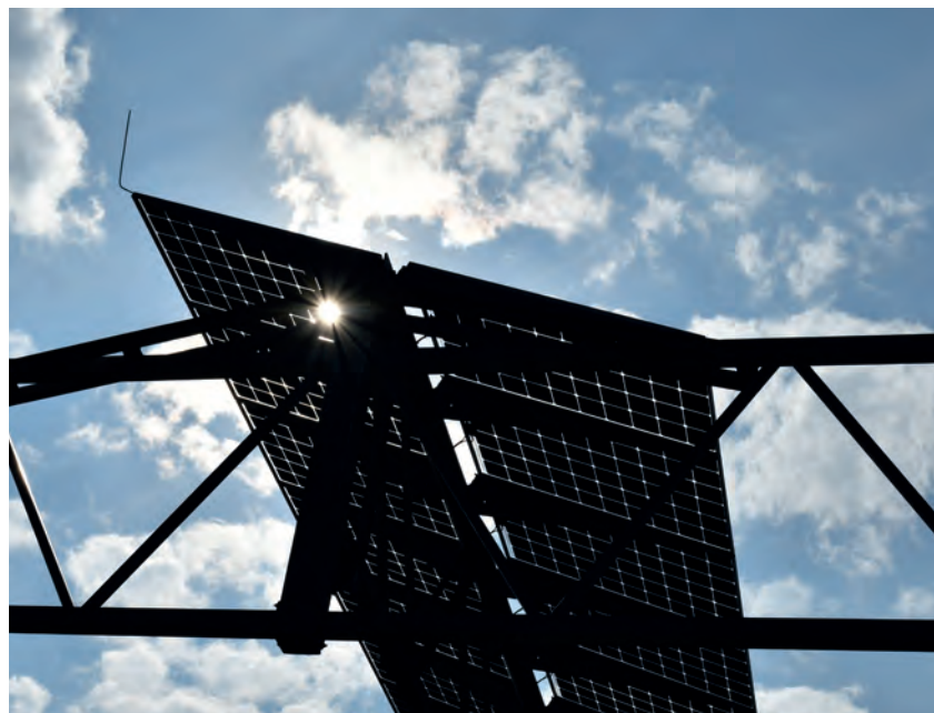
Abb. 19: Modulreihe mit bifazialen Modulen der Agri-PV-Anlage in Heggelbach © Fraunhofer ISE
