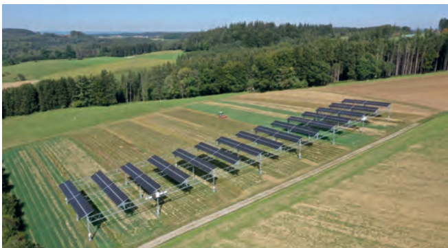
Abb. 56: Agri-PV-Anlage in Heggelbach mit einer Leistung von 194 kW p auf etwa einem Drittel Hektar © Fraunhofer ISE
