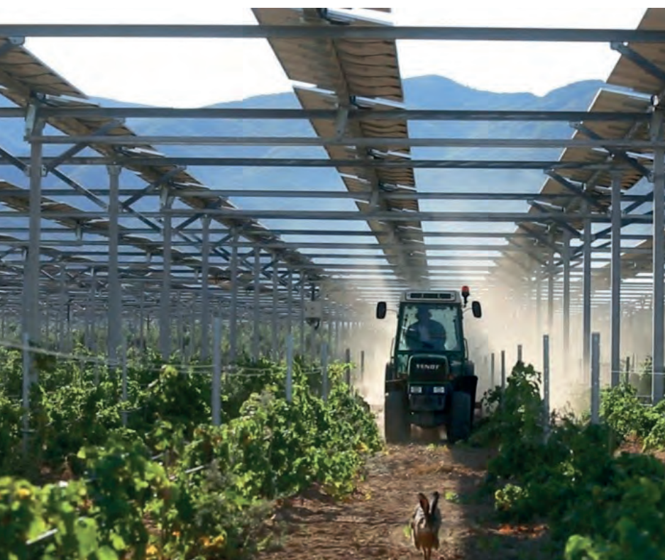
Abb. 49: Hoch aufgeständerte Anlage mit durchgängigen Modulreihen © Sun'Agri
