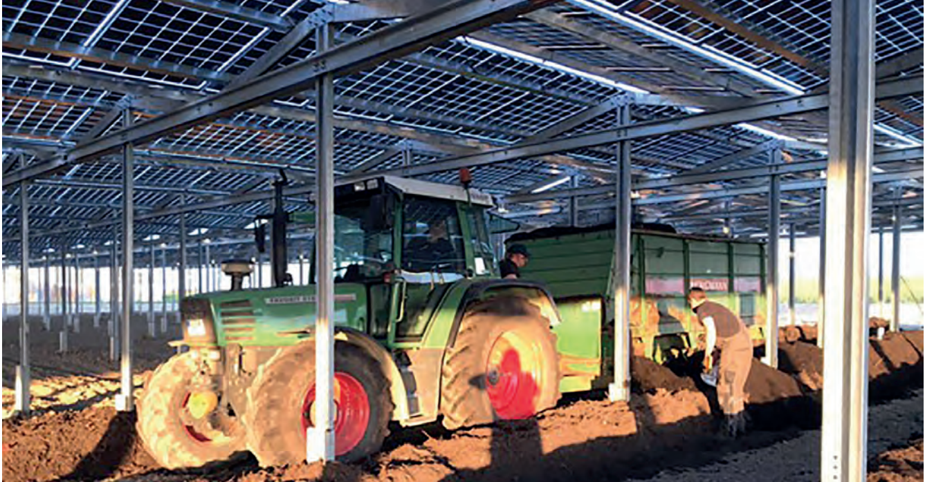
Abb. 58: Arbeiten in einer Agri-PV-Anlage unter den PV-Modulen © Fabian Karthaus
