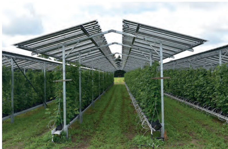
Abb. 43: PV-Module mit erweiterten Zellzwischenräumen und Schutzfunktion in den Niederlanden © BayWa r.e.
