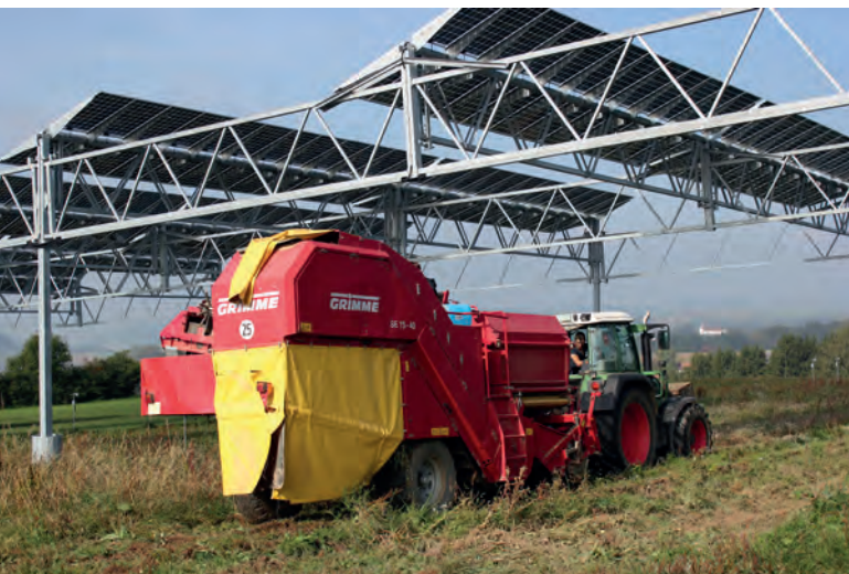
Abb. 42: Hoch aufgeständerte Anlage mit Möglichkeit zur Bewirtschaftung mit dem Kartoffelvollernter © Hofgemeinschaft Heggbach
