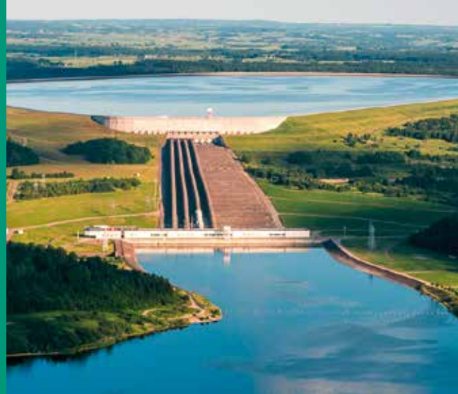
Pumpspeicherkraftwerk in Rönkhausen mit einer Leistung von 140 MW.
