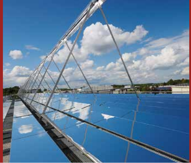
Linear konzentrierender Fresnel-Kollektor.
